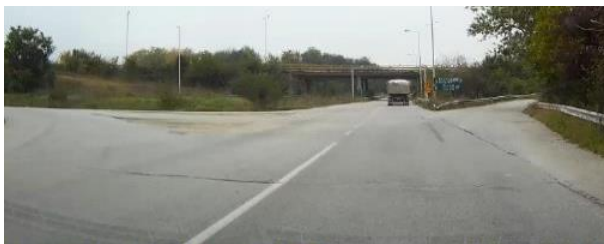
Відсутність каналізування руху на перехресті
