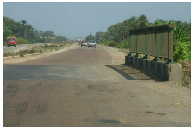
Мостова конструкція як жорстка перешкода
