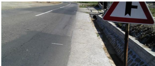
Небезпечна водовідвідна система та оголовок
