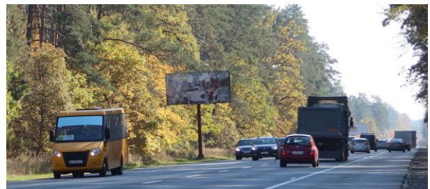
Дорога 1+1 з широкими твердими узбіччями
