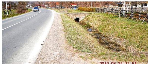
Небезпечна канава U-типу та оголовок
