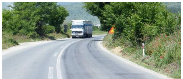
Незадовільна відстань видимості для зупинки автомобілю на кривій
