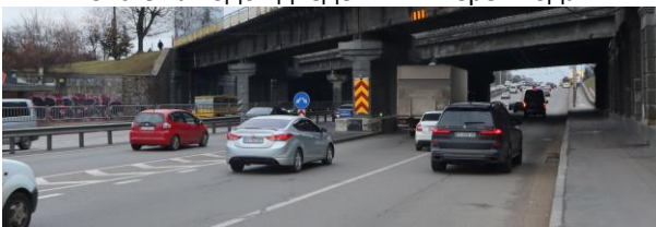
Жорсткі перешкоди на напрямних острівцях
